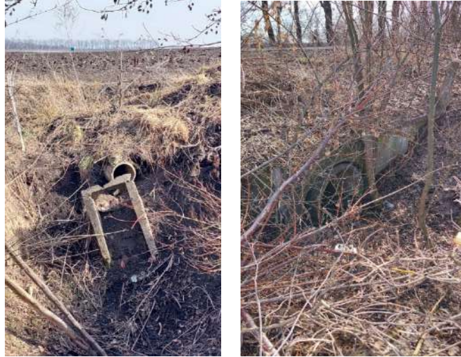
Фото 5-6. Меліоративний канал 2ГД-1 (ліва притока р.Тяжилівка).
