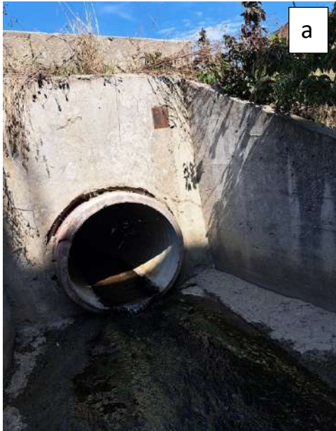
Рис. 2.4. Колектор (а) і русло річки (б) навпроти колектору. Біла лінія – межа поширення міток високих вод.
